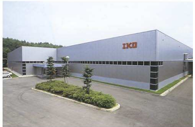
Производственная площадка в Гифу № 3
